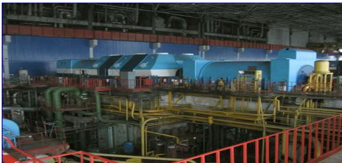
Рис. 14. Реконструируемый энергоблок №2 Рязанской ГРЭС.
