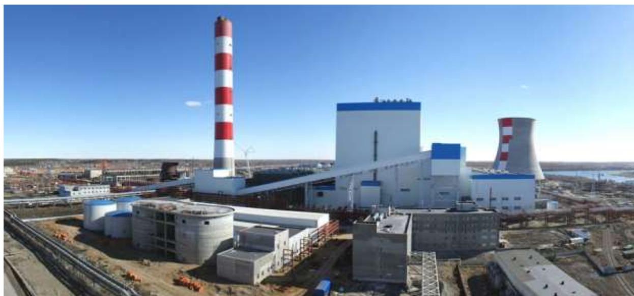
Рис. 13 Блок 10 Троицкой ГРЭС
