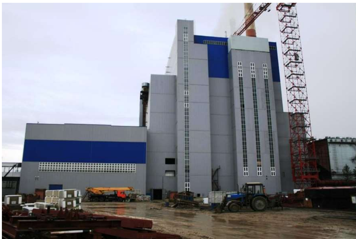
Рис.10 Блок № 9 Новочеркасской ГРЭС
